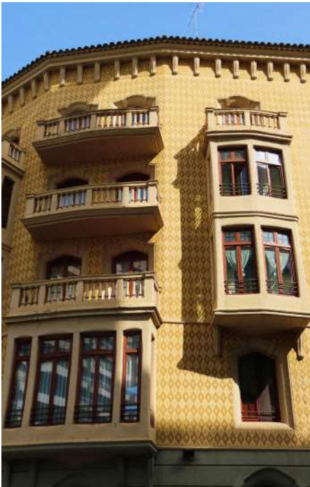
Façana de la Casa Xam-Mar.
