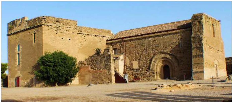
Vista general del Castell.
